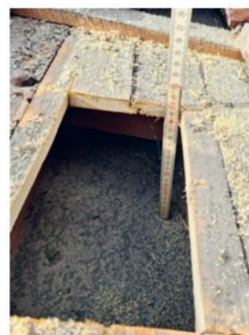
Sondage du toit—absence d'isolation
